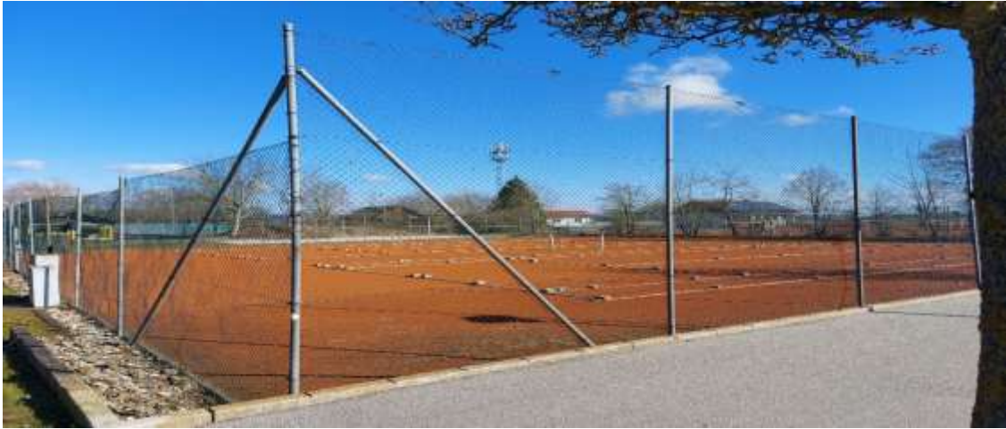
Sportanlage SO im Nordosten
